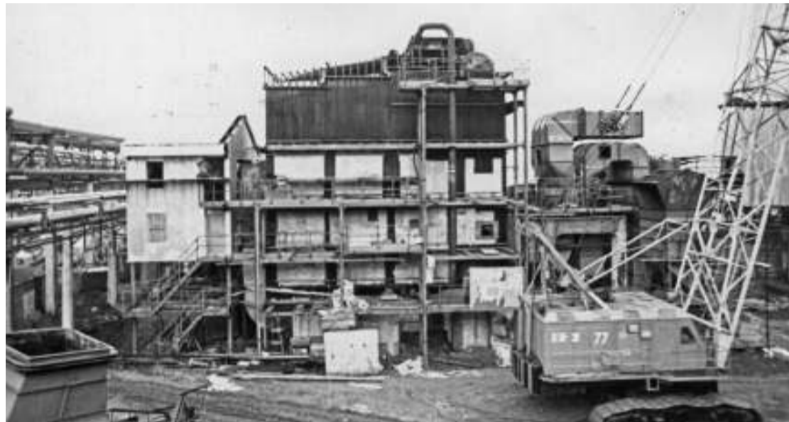
Монтаж котла на производстве карбамида
